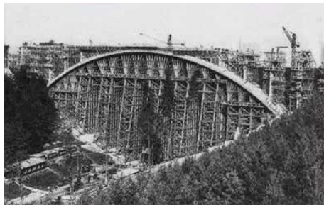
Abb. 7: Baustelle einer Bogenbrücke mit Lehrgerüst
